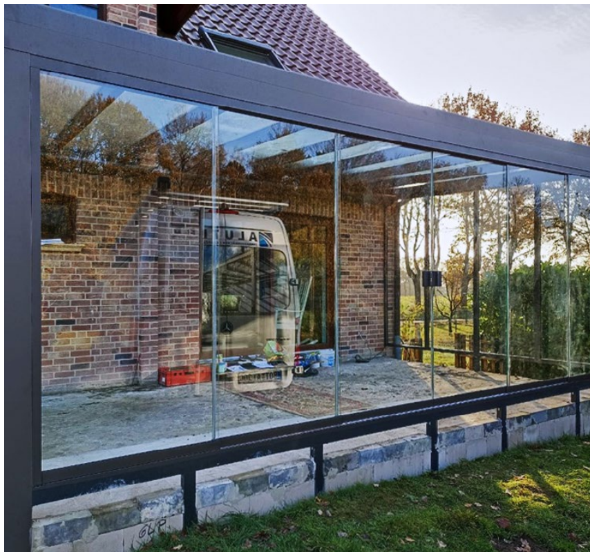
Aluminiowe fundamenty pasmowe pod system przesuwny
