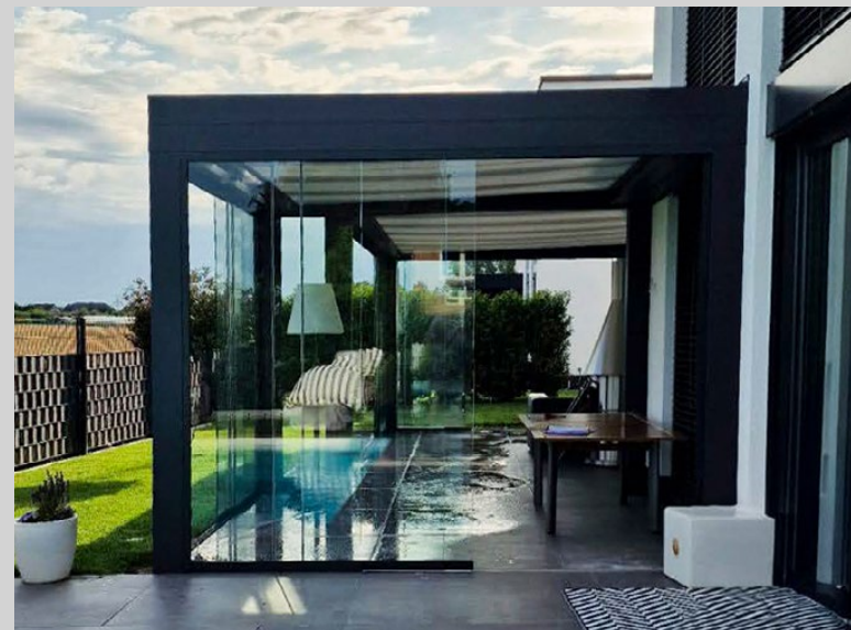
Dach płaski z ukrytym spadkiem
